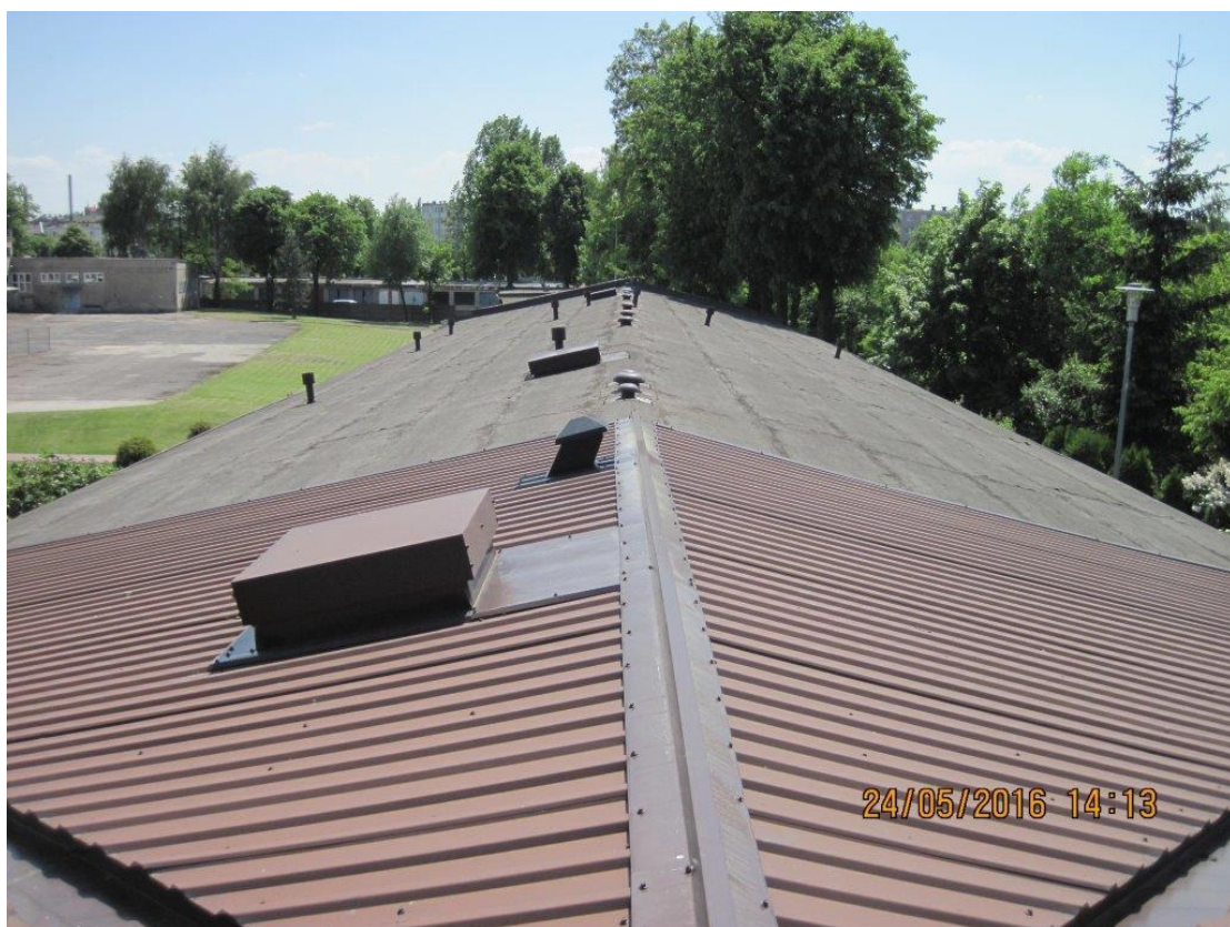
Zdj.3 Widok stanu istniejącego pokrycia dachowego.
