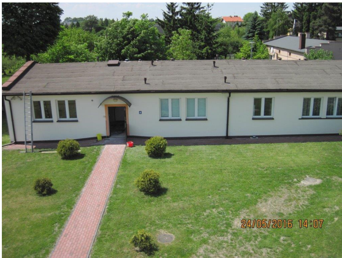
Zdj.2 Widok ogólny. Część dachu przeznaczona do remontu.
