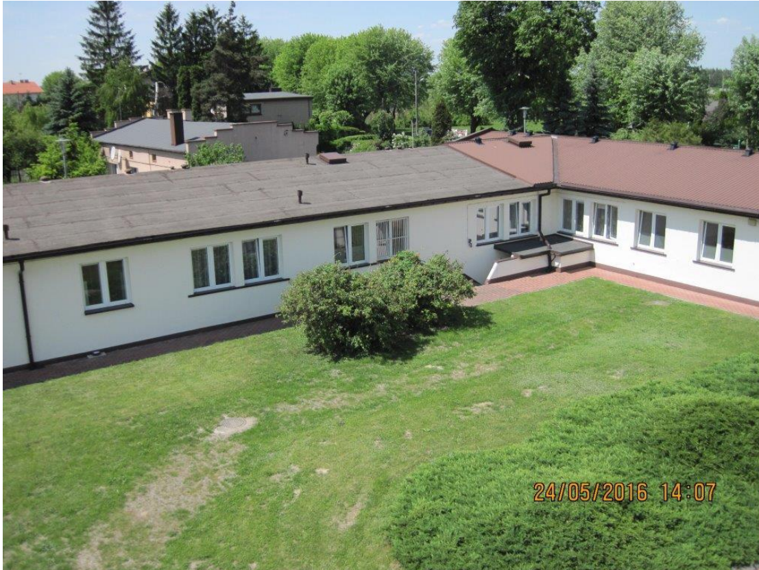
Zdj.1 Widok ogólny na budynek. Z prawej strony widoczna część dachu po remoncie.
