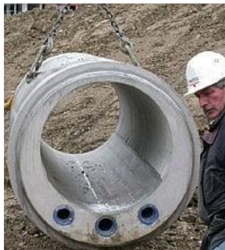
Rys. 2 Rury kanalizacyjne przystosowane do odzysku ciepła
